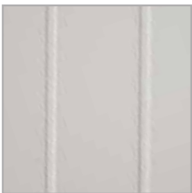
frezowanie na powierzchni skrzydła
