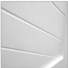
frezowanie na powierzchni skrzydła
