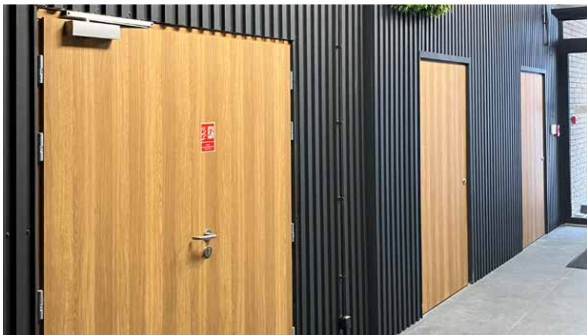
drzwi EI30 PLUS dwuskrzydłowe, ościeżnica regulowana drewniana
