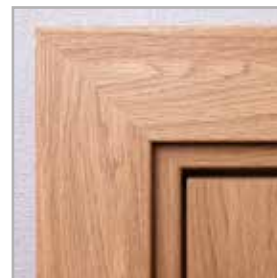
standardowe łączenie opasek pod kątem 45°
