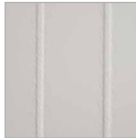
frezowanie na powierzchni skrzydła
