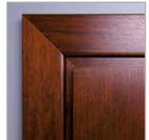
łączenie opasek pod kątem 45°
