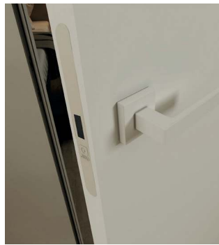
ZAMEK AGB Z BEŻOWĄ NAKŁADKĄ SZARA BLACHA ZACZEPOWA
