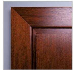
łączenie opasek pod kątem 45°
